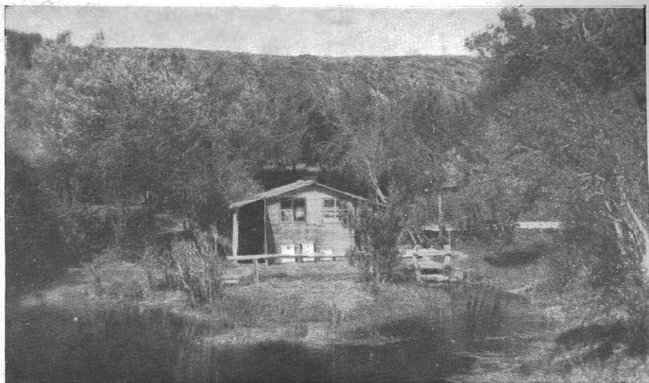
FIG. 3. — Vista de la primera estación de Piscicultura de Bariloche, cuya ubicación y construcción fué obra del Sr. J. Titcomb, en el año 1904.
