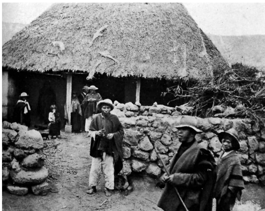
Ilustración VI. 2. Choza de indios Quichuas cerca de Riobamba
