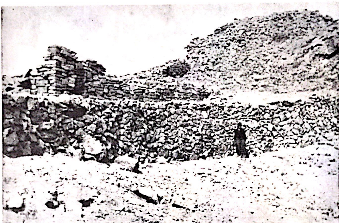
Ruinas de casas delante de la entrada al Corral Grande
