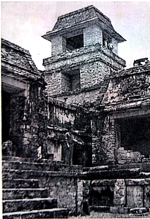
La torre de cuatro pisos del «Palacio» en Palenque (Chiapas-México).
