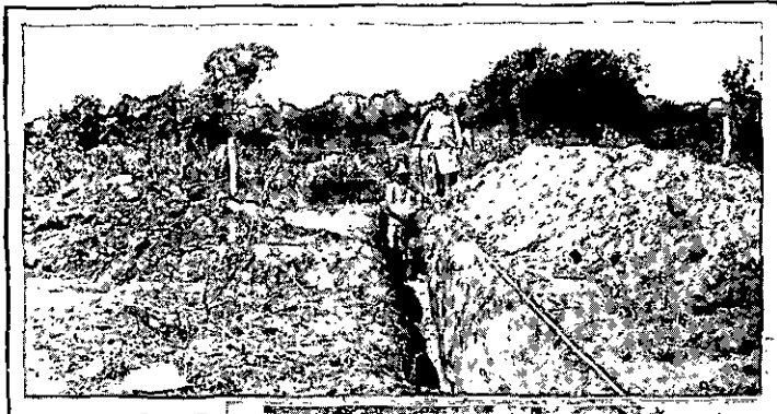
8.—Zanja transversal C D en el túmulo de la Pesquería Nicolini.
