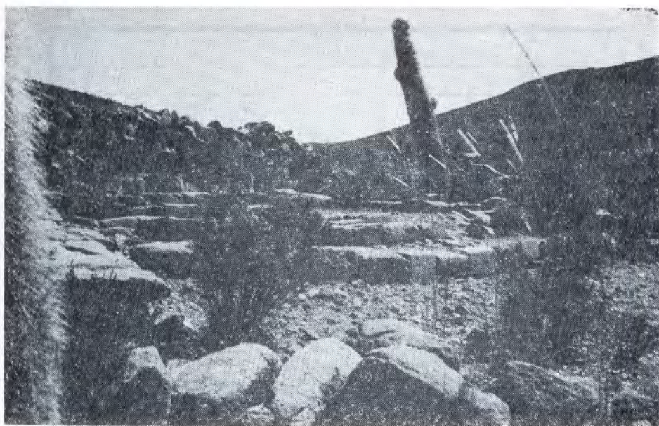
FIGURA 1: Monumento escalonado visto de frente. Firca seca limitando la parte posterior del monumento que ha sido construido con piedras canteadas.
