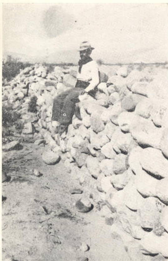
Fig. 6. — Banquina en el paramento interno del muro de cintura, frente al edificio 3.
