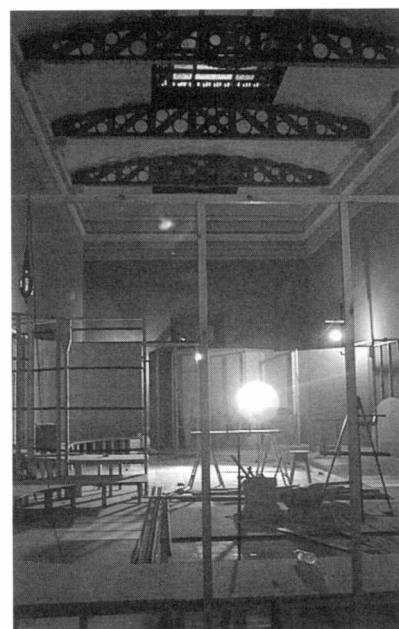
Montaje de infraestructura.
