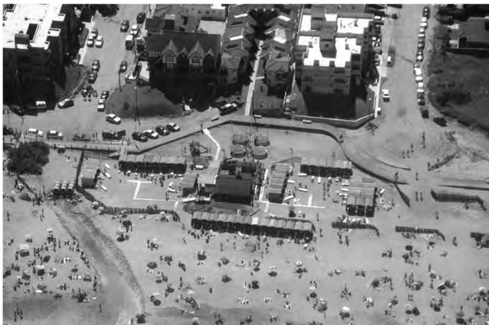
Figura 11: Villa Gesell (Buenos Aires) 2009. Pluviales que terminan en la playa. Obsérvese que los cortes producidos en la playa duran mucho más que la tormenta. Foto: Municipalidad de V. Gesell.
