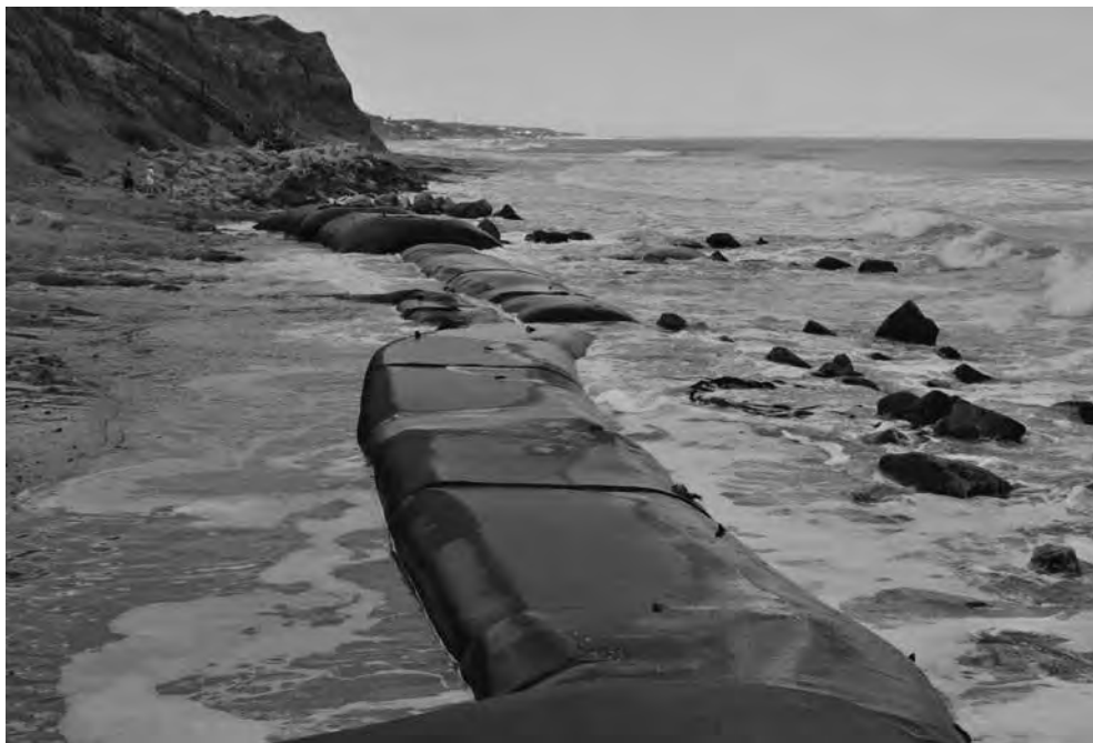
Figura 16: Acantilados de Mar del Plata (partido de General Pueyrredón, Buenos Aires) 2012. Geotextiles empleados en la confección de los rompeolas. Foto: F. Isla.
