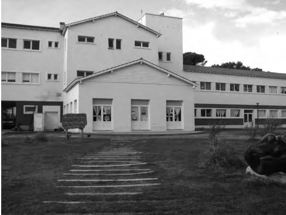
Figura 7. Vista del actual edificio donde funciona el Museo Vicente Di Martino. Foto: C. Celsi.
