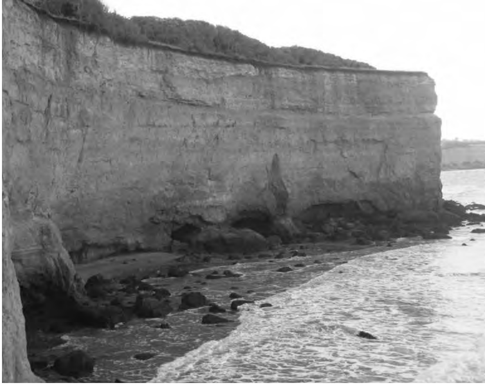
Figura 7: Barranca de los Lobos, Mar del Plata (partido de General Pueyrredón, Buenos Aires) 2010. Acción del mar formando "mediacañas", con el posterior derrumbe del acantilado. Foto: M. Taglioretti.
