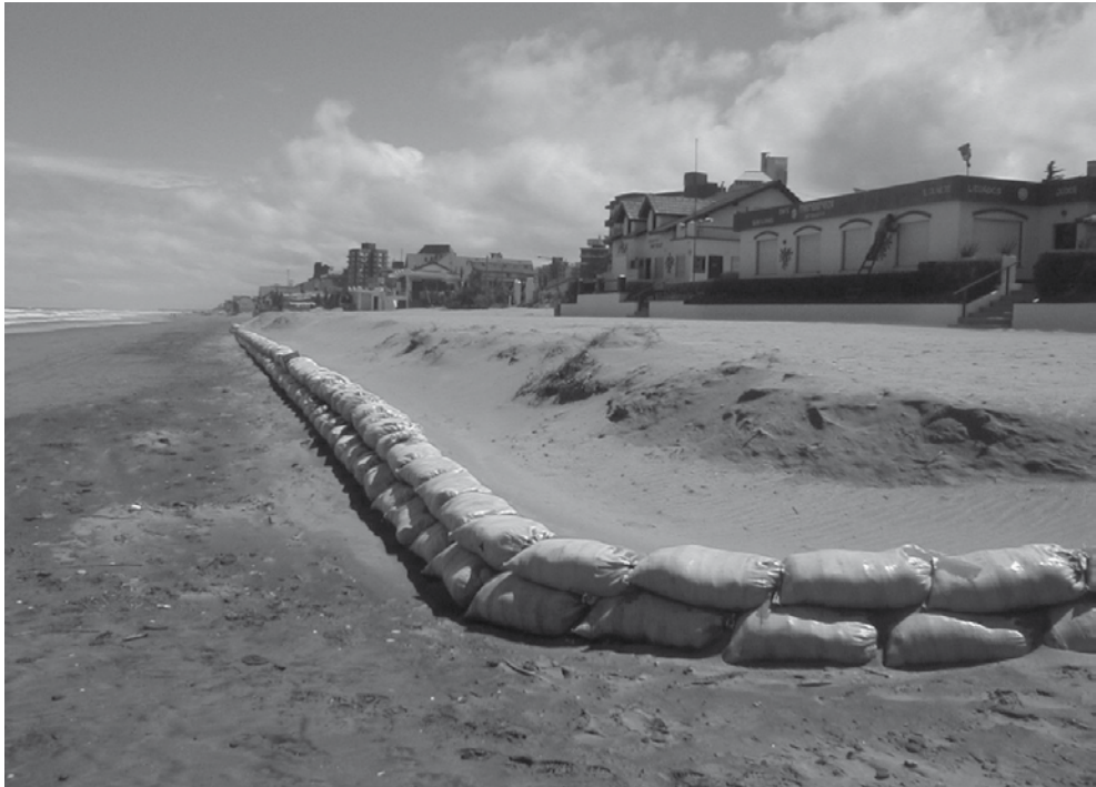
Figura 8: Villa Gesell (Buenos Aires) 2004. Erosión de la costa frente a balnearios y acción paliativa (pero inútil) mediante bolsas con arena. Foto: G. R. Bértola.
