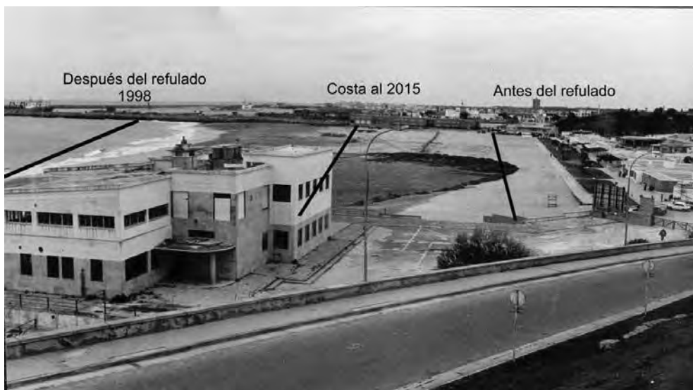
Figura 17. Playa Grande, Mar del Plata (partido de General Pueyrredón, Buenos Aires) 1998. Relleno sedimentario y comparación del antes, durante y después del mismo. Foto: G. R. Bértola.
