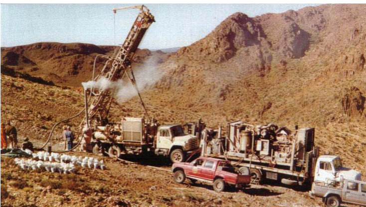
Figura 3.12: Perforación con recuperación de polvo.
