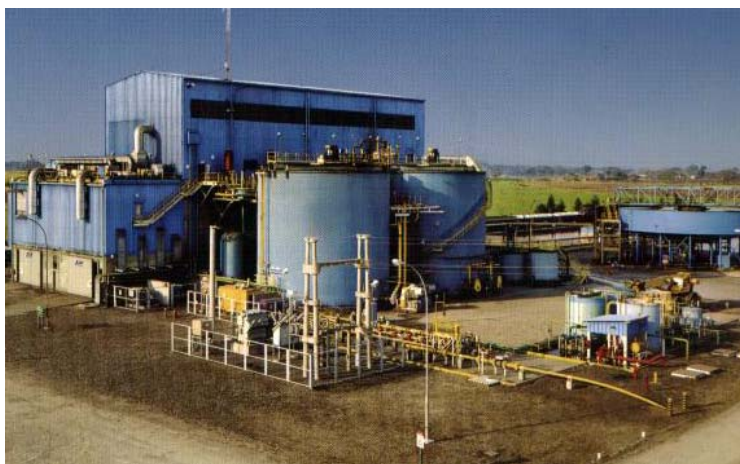
Figura 6.13: Planta de tratamiento del agua del mineraloducto proveniente de la mina Bajo de la Alumbreira, en Cruz del Norte, Tucumán.
