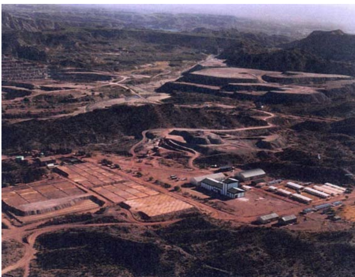
Figura 6.7: El Complejo Minero Sierra Pintada (uranio), en San Rafael, Mendoza, es un establecimiento que siempre estuvo controlado en materia ambiental. De acuerdo a los informes del Ministerio de Ambiente de Mendoza, nunca produjo daños ambientales en su entorno.
