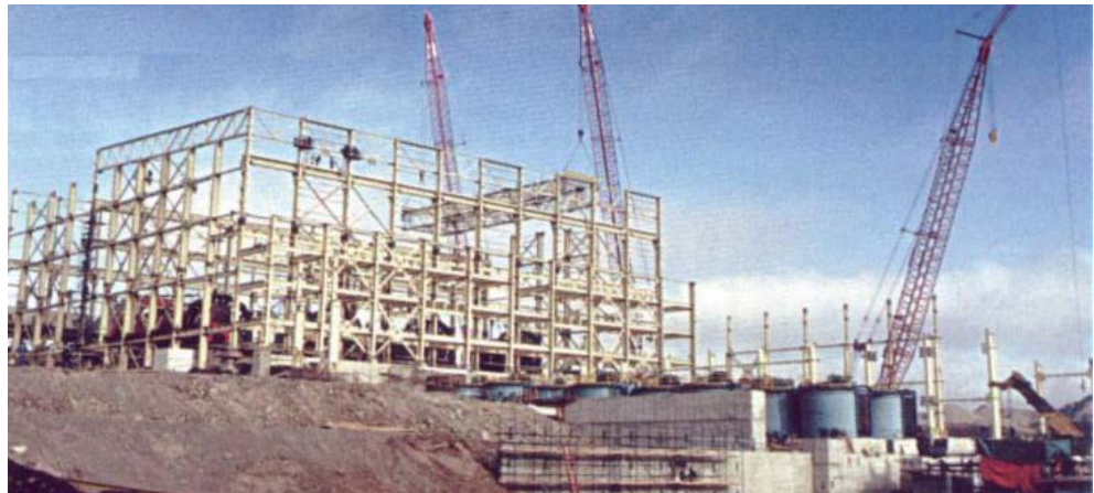
Figura 5.1. Bajo de la Alumbrera. Construcción de la obra civil de la planta de concentración
