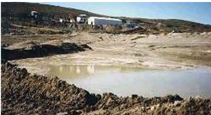
Figura 6.18. Planta de concentración de la mina Angela (polimetálica, Chubut), antes de la remediación
