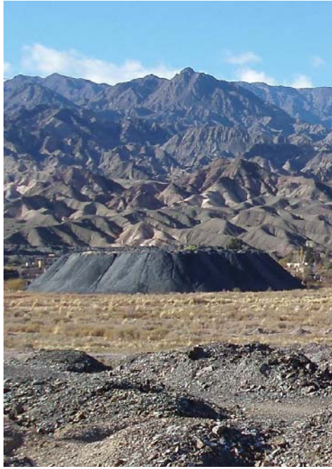
Figura 6.10: Escombrera en Calingasta, San Juan. Cuando no existían normas ambientales, estas escombreras se depositaron en el ancho cauce del río de los Patos sin ninguna protección. Hoy no se permite este tipo de disposición sin haber tomado todas las precauciones para proteger el recurso hídrico
