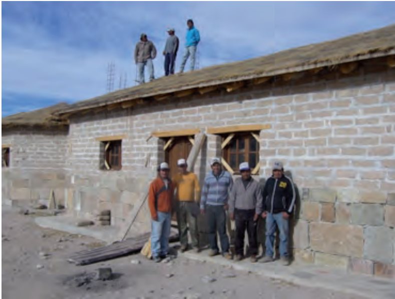
Figura 6. Museo Rural Comunitario de Barranca Larga durante su construcción en 2009.
