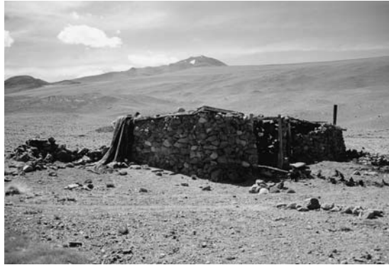
Figura 75. Vista general de Río del Macho Muerto 3 Figure 75. General view of Macho Muerto River 3
