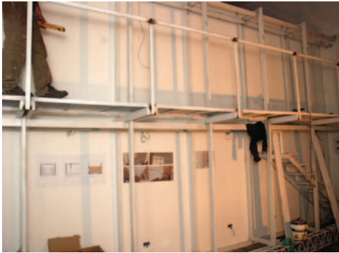
/// Montaje de la estructura principal en la nueva Tienda de Recuerdos.
